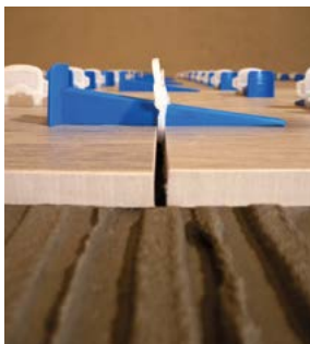
Nach der Feinnivellierung
